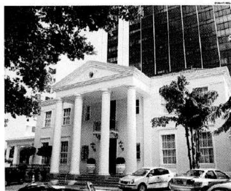
O antigo e o novo. Construções como o Victory Tower mantêm a fachada original
