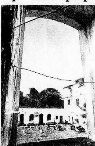
No interior do Forte de Santo Antônio as obras estão paradas
